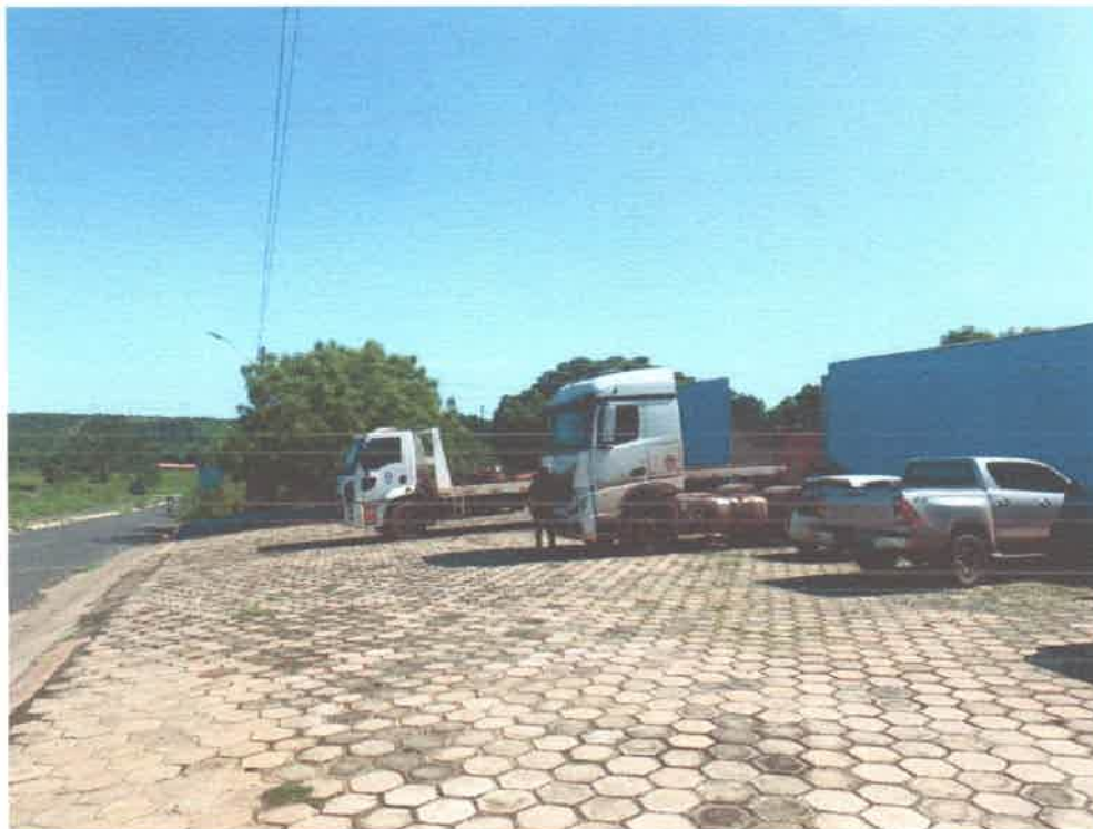
FOTO 07 – PARTE EXTERNA (GARAGEM)
