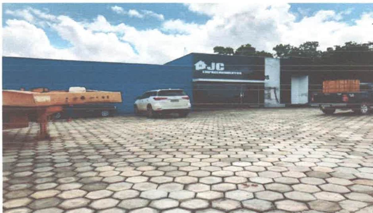
FOTO 03 – PARTE EXTERNA (GARAGEM)
