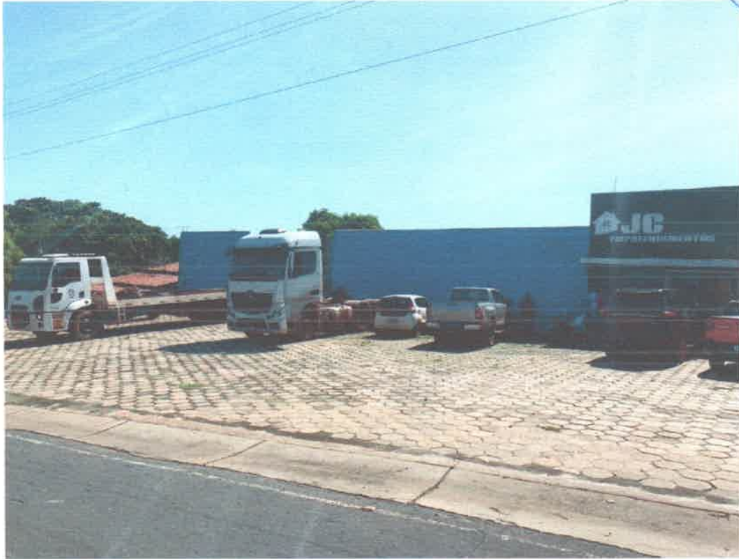
FOTO 09 – PARTE EXTERNA (GARAGEM)
