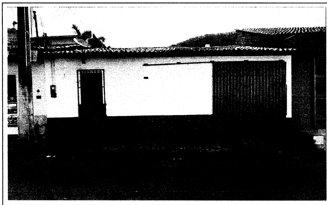
VISTA DA FACHADA DO EDIFÍCIO
