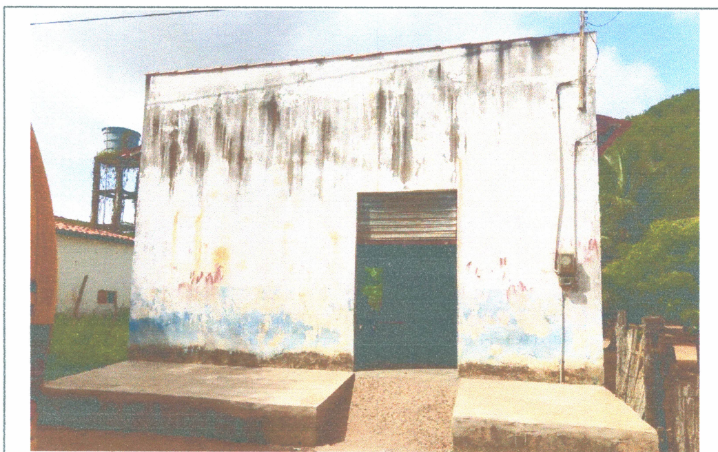
VISTA DA FACHADA DO EDIFÍCIO
