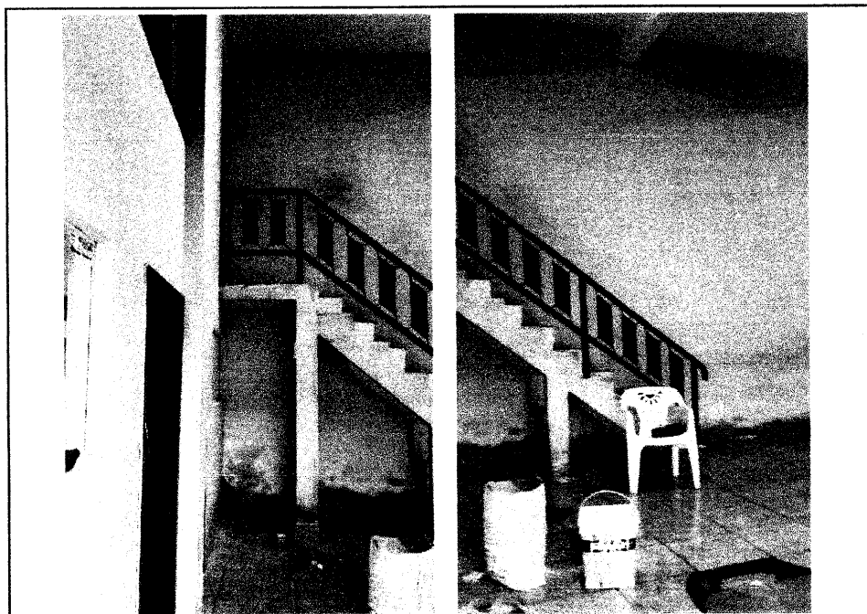
Foto 05 : INTERIOR DO EDIFÍCIO
