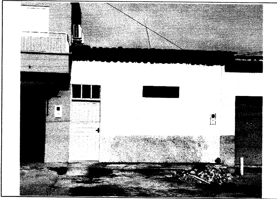
Foto 01 : FACHADA PRINCIPAL- AV. ULISSES GUIMARÃES
