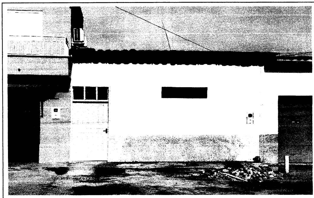
VISTA DA FACHADA DO EDIFÍCIO
